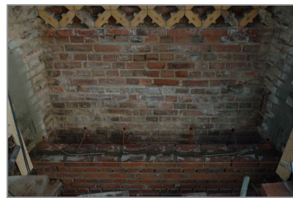
Errichtung der neuen Vorsatzschale (Foto: Deisenroth)
